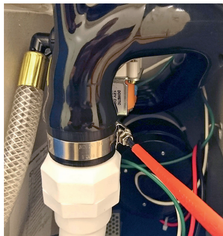
6. Klammer på slanganslutning
